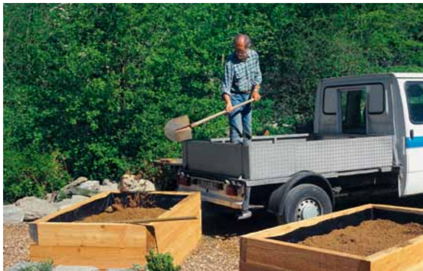
② ... dann folgt das Befüllen mit mineralischem Schüttgut ...
